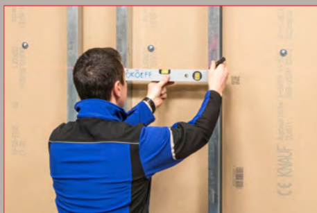
1) Ausmessen und anzeichnen der benötigten Löcher
