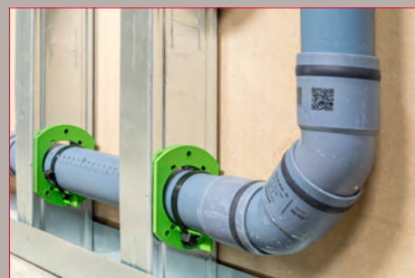
6) Eine schonende Verlegung von Ablaufrohren ist damit ebenfalls möglich.
