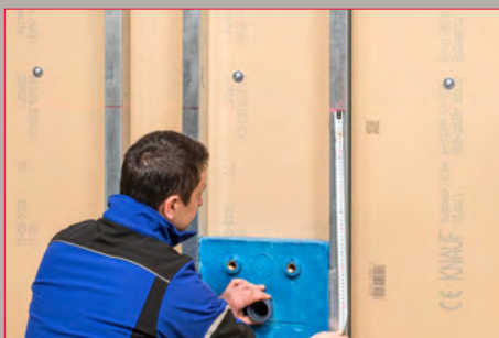
2) Befestigen der Installationsbox (Beispiel)
